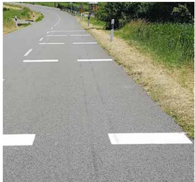
Berbourg, Lellig, Manternach, Münschecker : A l'entrée des 4 villages, des marquages été mis pour ralentir la circulation.
